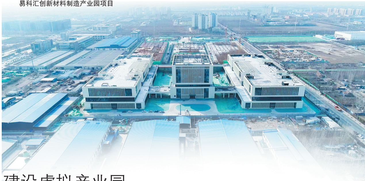
易科汇创新材料制造产业园项目
