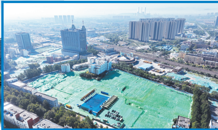
淄博火车站北广场片区第一批还迁房项目开工。 资料照片
