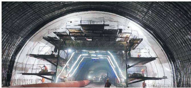
施工人员在隧道内进行二衬钢筋绑扎。
