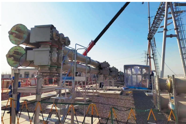
500千伏惠民变电站新建间隔GIS安装
