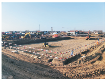
变电站换填法地基基础施工
