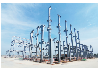
变电站综合楼建设初期的钢结构主体梁柱
