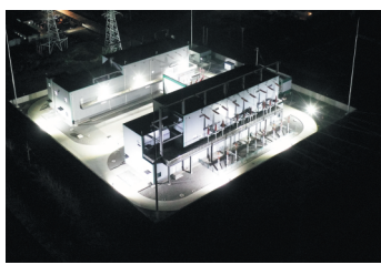
夜间的220千伏安姜变电站灯火通明。
