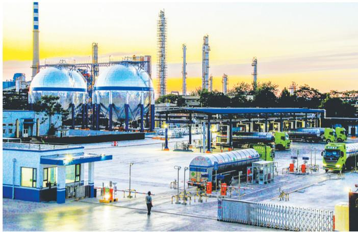
齐鲁石化-胜利油田百万吨级ccus项目——齐鲁石化100万吨二氧化碳综合利用回收装置 曹业琦 摄
