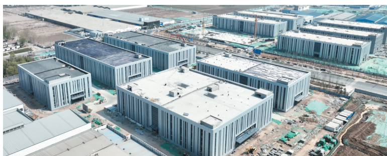
北方医疗器械产业城(一期)正在加紧施工。
