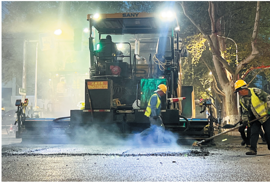
4月12日晚,东一路与商场路交叉口,施工人员正在连夜施工中。
