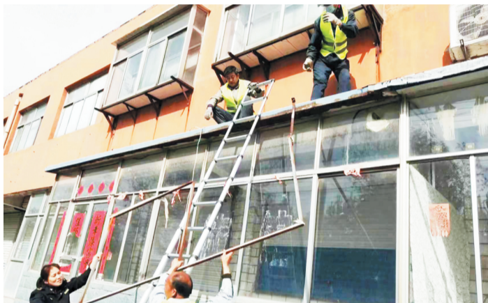
工作人员拆除破损的牌匾。
