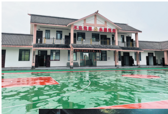
▲石柱县王场镇石溪村党群服务中心
