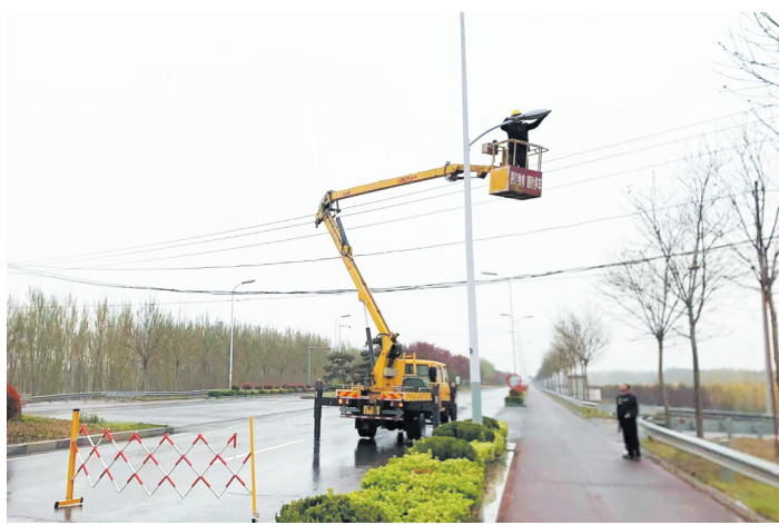
维修作业人员给路灯“体检”。
