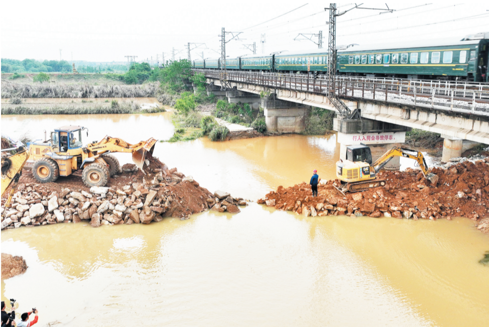
江西省丰城市丽村镇高山村溃口封堵现场(无人机照片,5月7日摄) 新华社发
