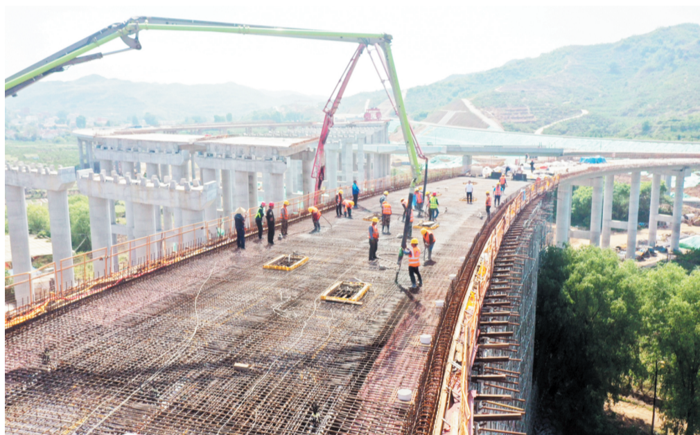
鲁山互通C匝道桥第一联现浇箱梁施工现场
