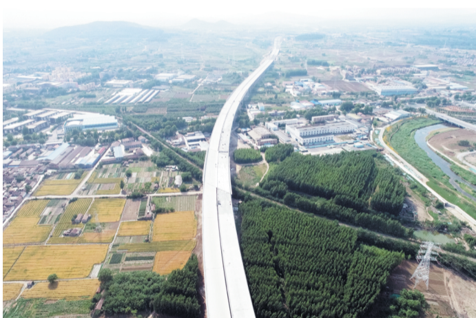
5月24日,孝妇河特大桥最后一联桥面铺装完成。
