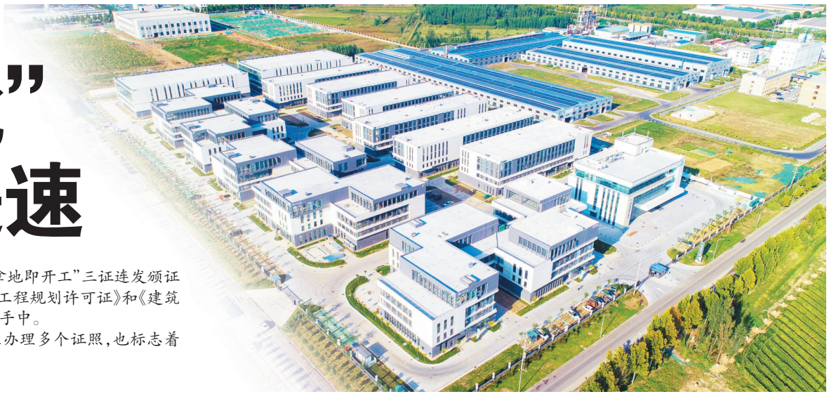
高青经济开发区产业园区内,在建项目有序推进中。
