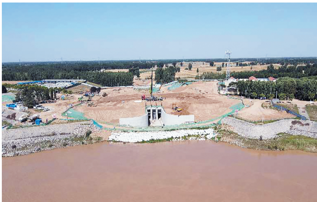
黄河马扎子涵闸闸门安装施工现场
