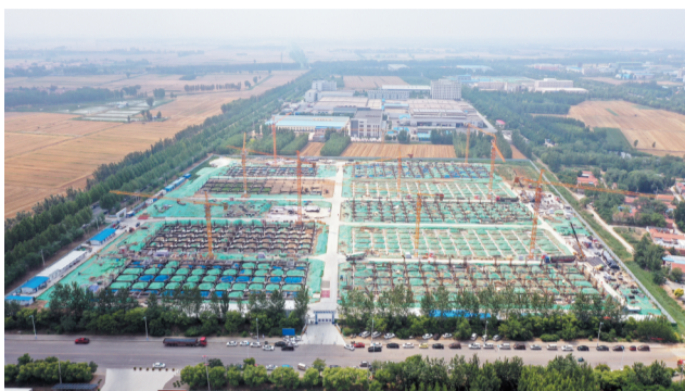
正在建设中的滨州市(高新区)食品产业示范园一期工程 大众日报淄博融媒体中心记者 齐国利
