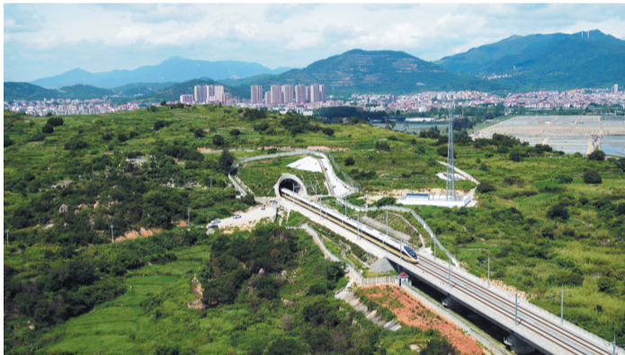
6月29日,试验列车通过海尾隧道。
