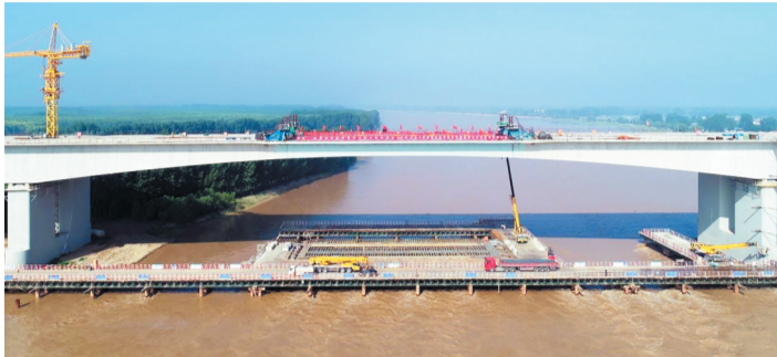
滨州黄河大桥主桥顺利合龙。
