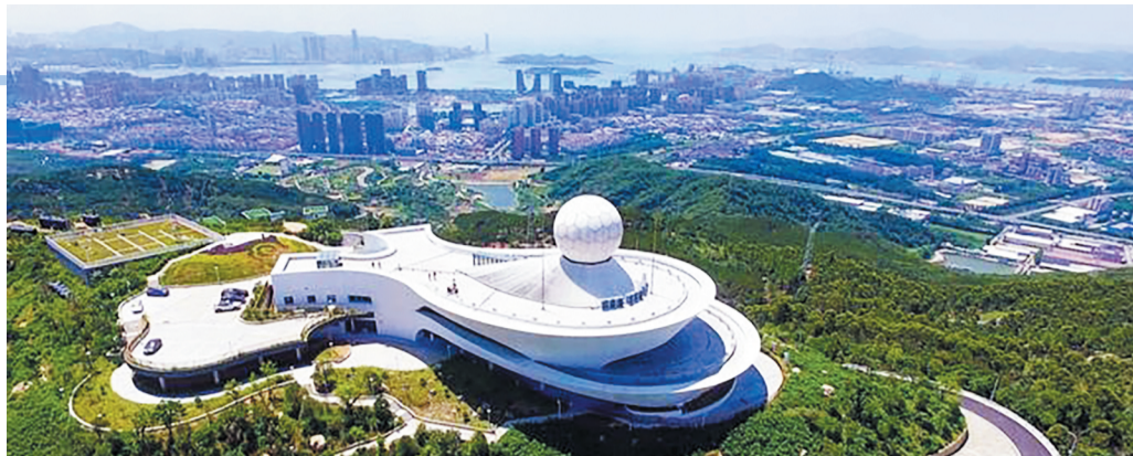
落户厦门天语舟气象科技园的双偏振多普勒天气雷达。
