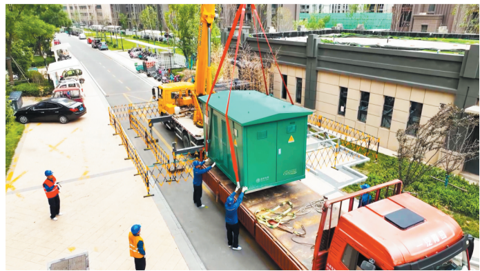
供电人员运输箱变准备抢修。
