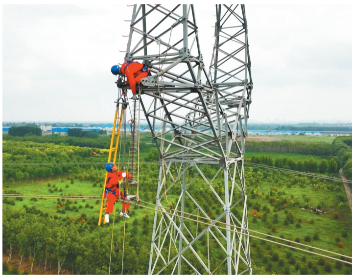
供电人员更换绝缘子。
