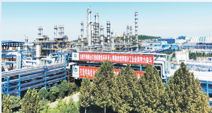
齐翔腾达45万吨/年低碳烷烃脱氢制烯烃综合利用项目 资料照片
