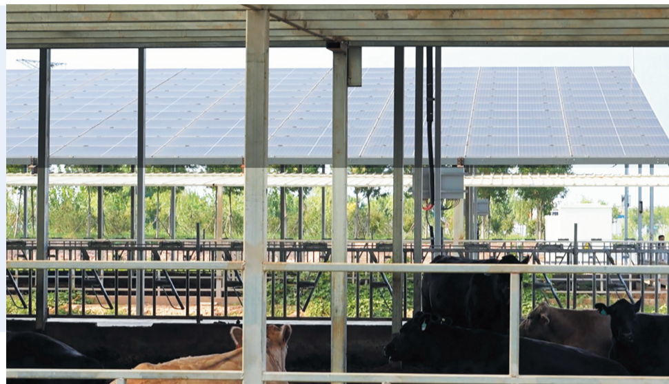
华能高青唐坊牧光互补光伏发电项目
