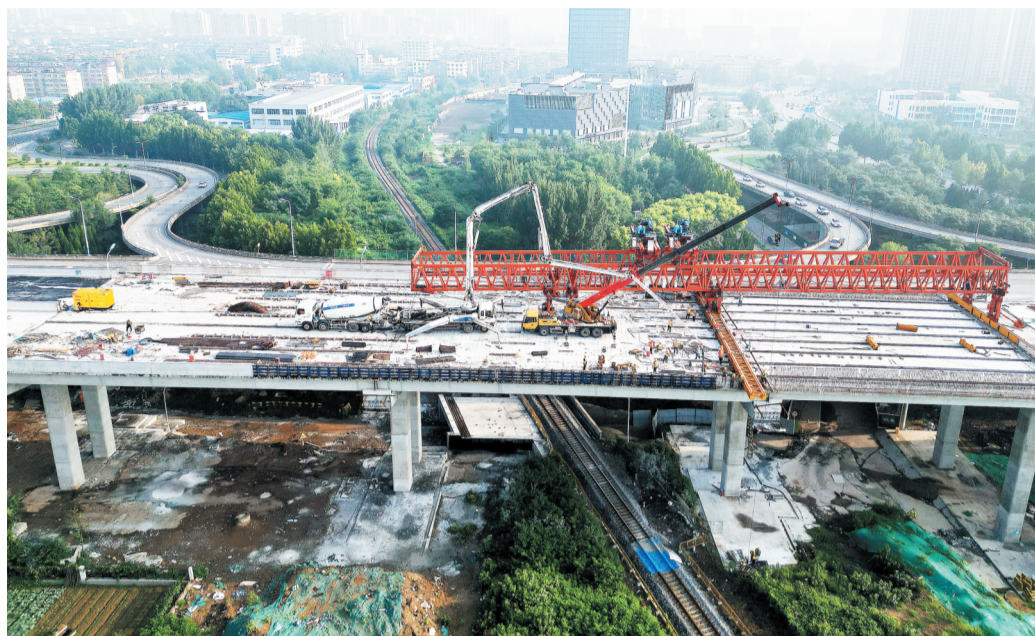
8月20日,随着最后一块预制箱梁架设完毕,淄博快速路网昌国路上跨张博铁路立交桥工程箱梁架设施工顺利完成。
