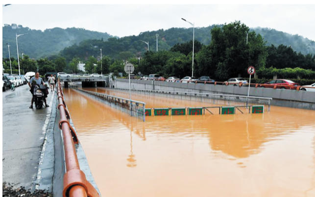
福州市仓山区盖山镇首山地下通道积水严重。
