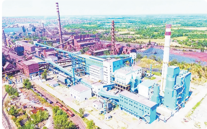
河钢集团塞尔维亚钢铁公司厂区 受访企业供图
