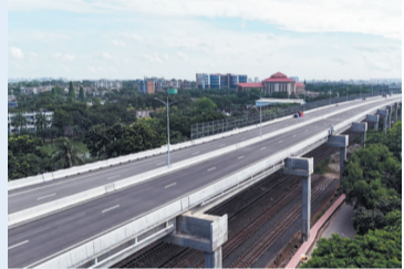
孟加拉国达卡机场高架快速路项目（一期）通车。
