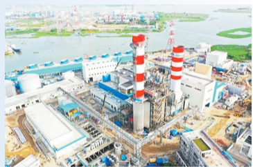
孟加拉国UNIQUE玛格丽特三期9HA燃机单循环发电机组
