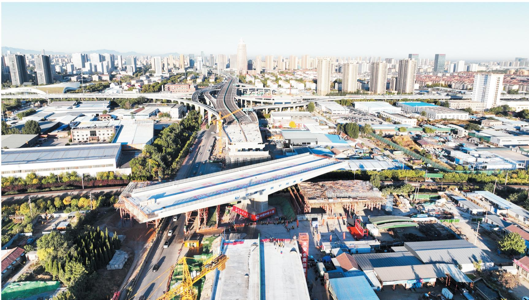
10月20日清晨,淄博市快速路鲁泰大道上跨张东铁路立交桥施工现场,在主牵引索的环绕下,2台同步的自动牵引设备控制桥体以每分钟1.1度速率缓缓旋转,最终到达88度的设计位置,淄博市城建史上首座跨铁路转体桥梁顺利落位,成功转体。鲁泰大道快速路主线桥计划于年内实现全线通车。
