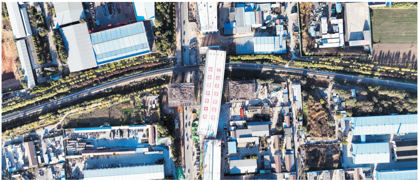
淄博市快速路鲁泰大道上跨张东铁路立交桥成功转体。
