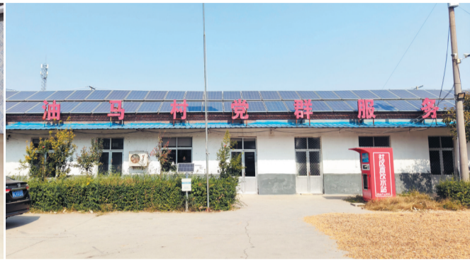
油马村屋顶上整齐排列的光伏组件。
