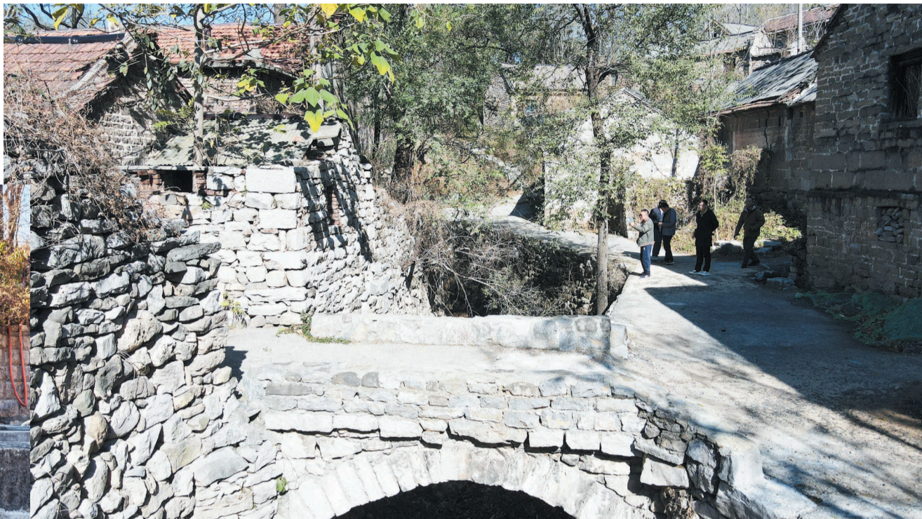
石屋石桥是山王庄村的典型建筑。
