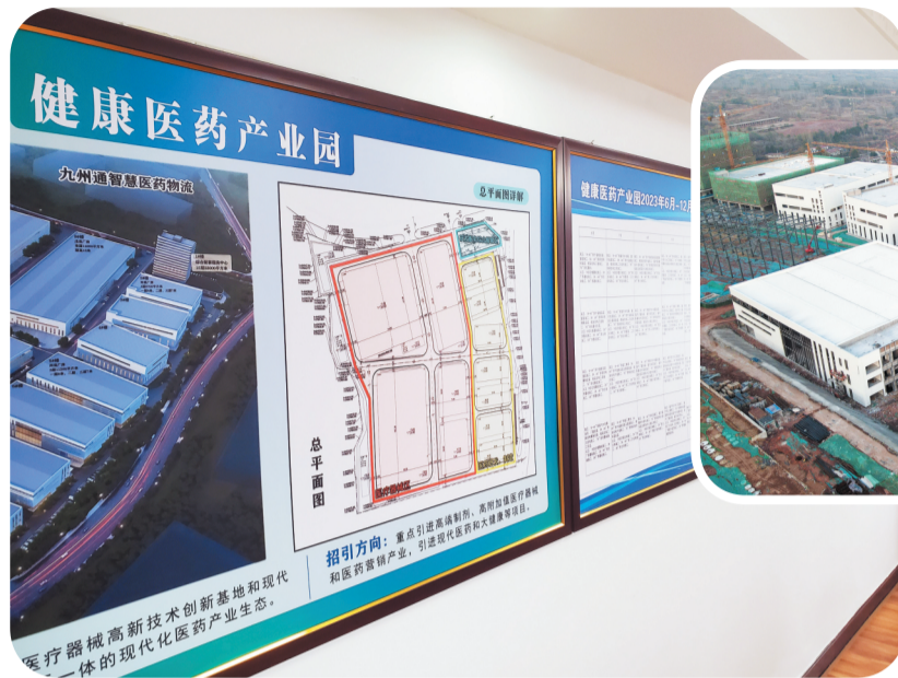
▲ 健康医药产业园建设现场
