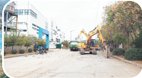
▲博山健康医药产业园内的道路正在维修施工。
