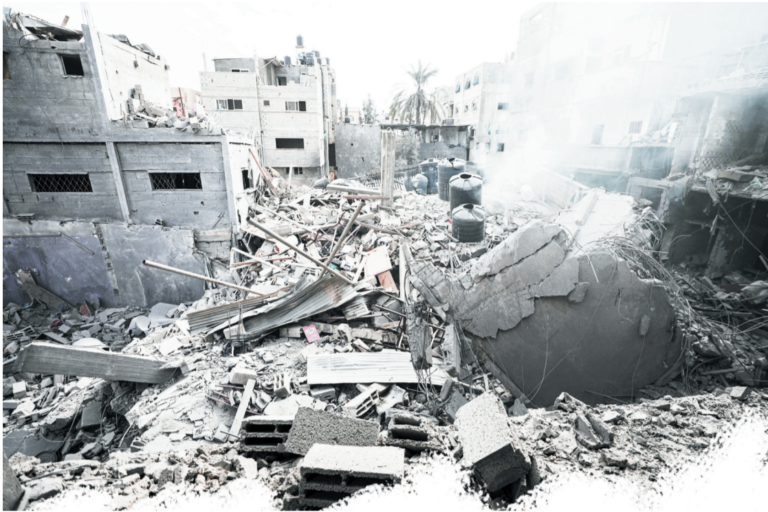
11月13日,在加沙地带中部地区拍摄的一个遭以色列空袭的建筑废墟。
