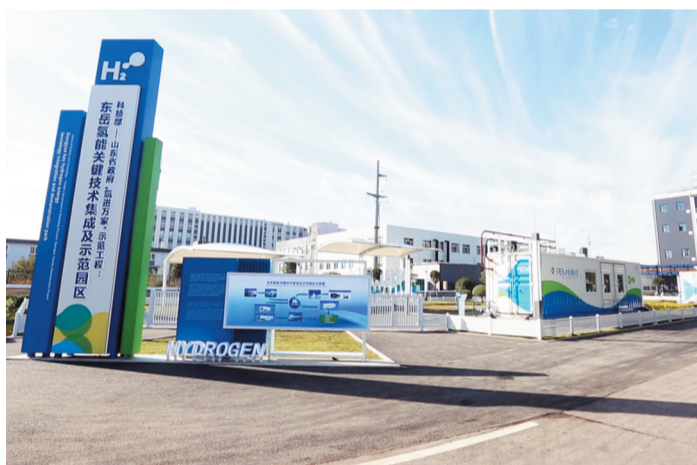
“东岳氢能关键技术集成及示范园区项目”现场。
