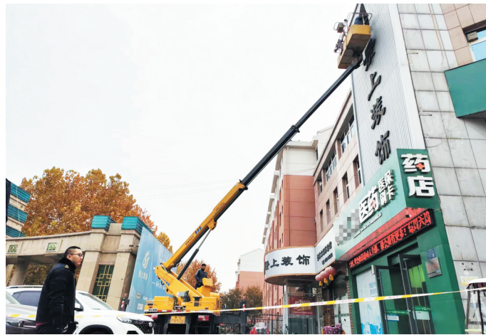
执法队员拆除无主广告牌。
