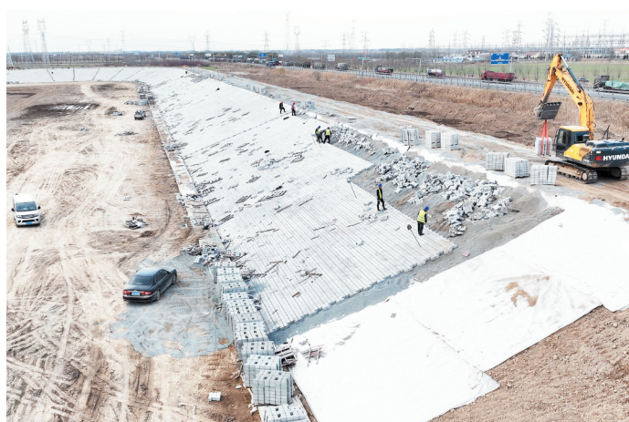
坝坡上,工人们正在进行坝坡连锁块和土工布的铺装。
