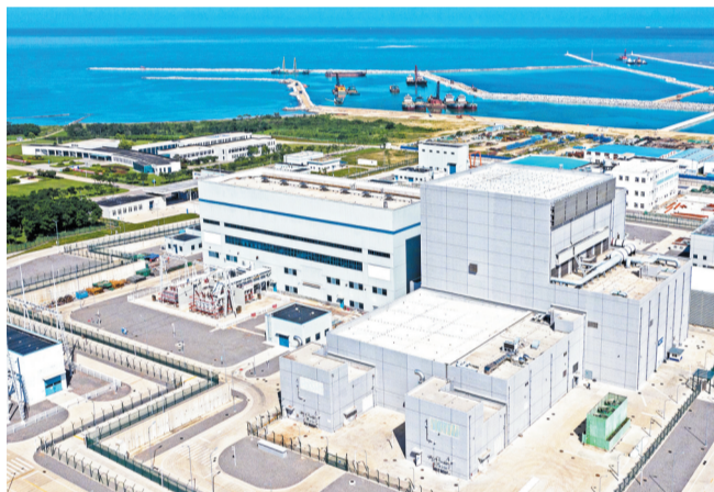
华能石岛湾高温气冷堆示范工程外景(资料照片)。
