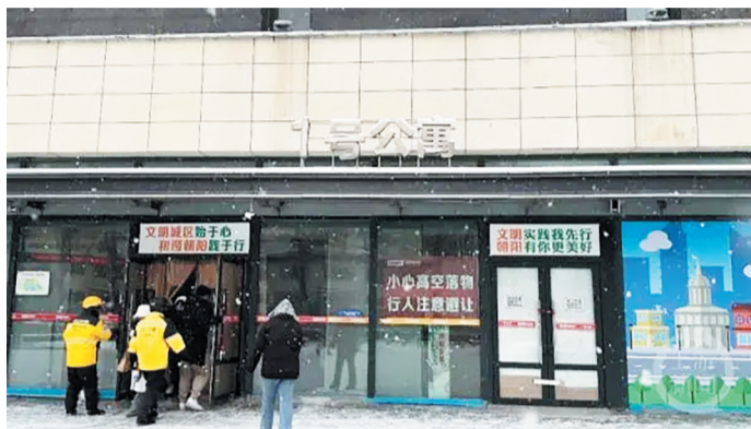
11月27日,事发公寓楼入口张贴着“小心高空落物”标识。 上游新闻供图
