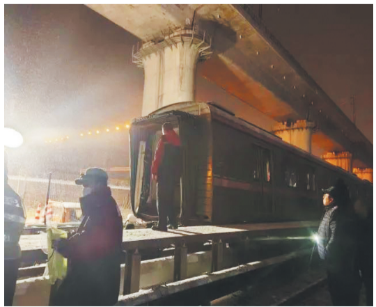
昌平线地铁车厢断裂处,工程人员排查现场。
