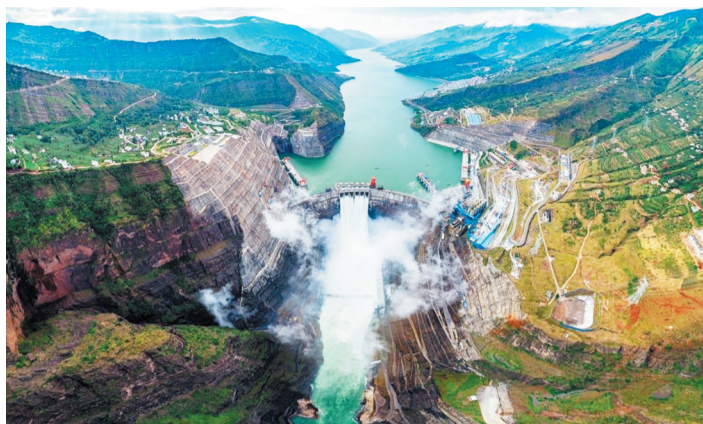
白鹤滩水电站
