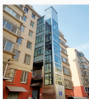
旧楼加装电梯
