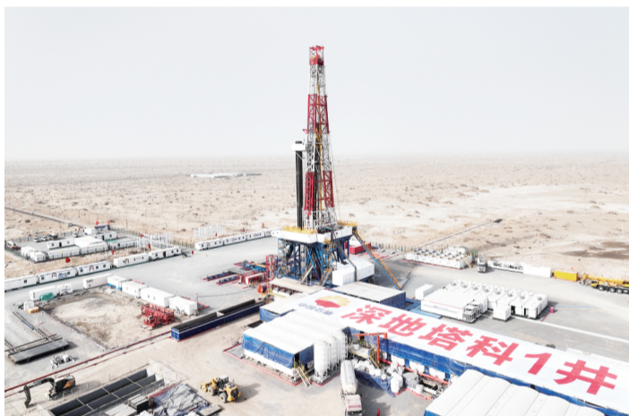
这是3月4日在新疆塔克拉玛干沙漠拍摄的深地塔科1井(无人机照片)。
