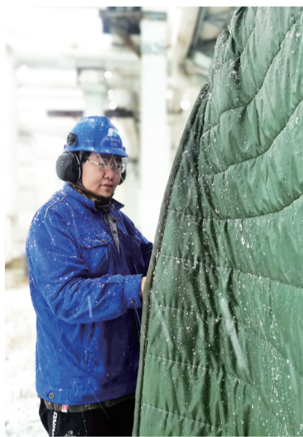
风雪中，检修人员为设备加装保温棉。
