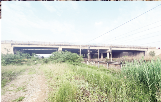
拆除前的原桥 资料照片
