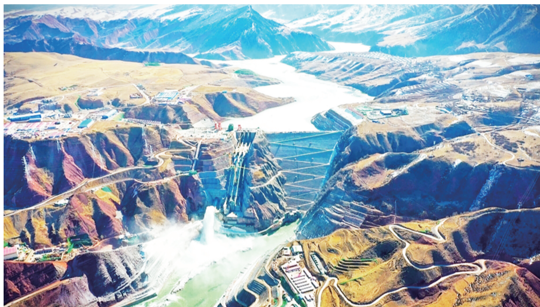
3月31日拍摄的玛尔挡水电站(无人机照片)。
