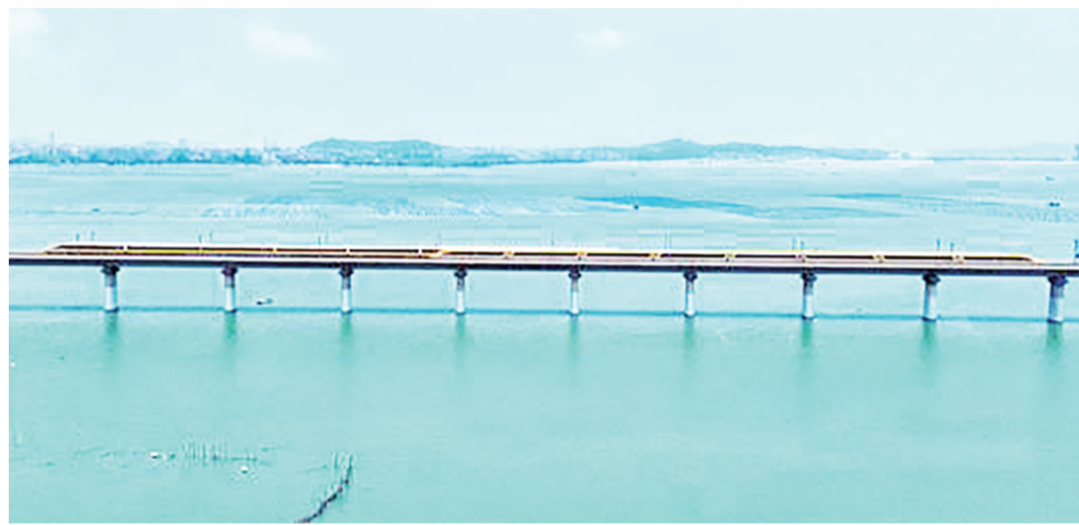
2023年6月28日,CR450动车组试验列车在涠洲湾跨海大桥交会运行,单列最高运行时速达到453公里。(铁科院集团公司供图)
