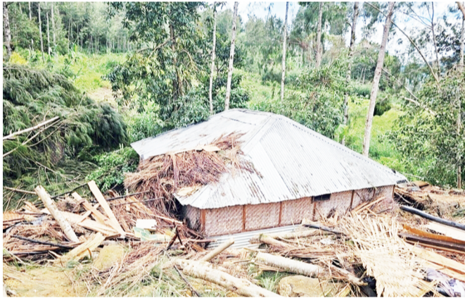
山体滑坡现场
