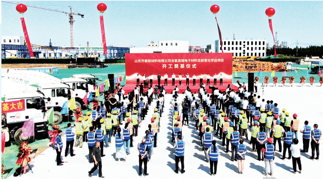
齐氟新材料含氟高端电子材料及配套化学品项目开工奠基。
