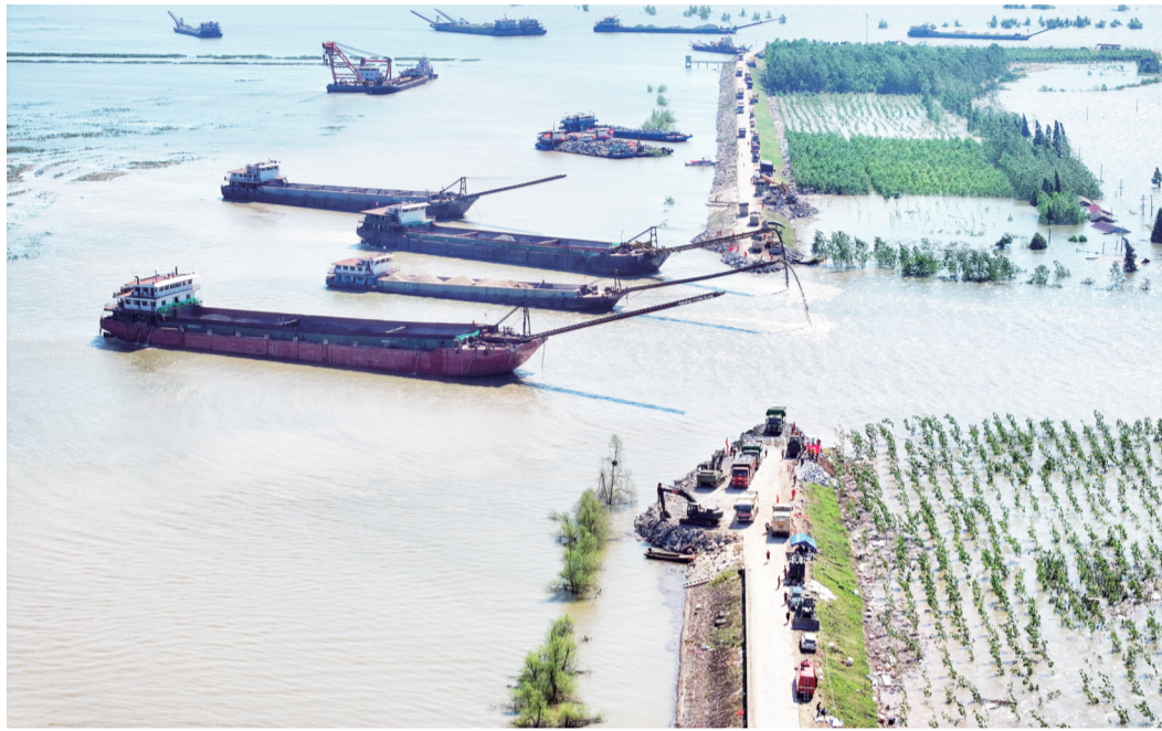
7月7日,在岳阳市华容县团洲垸洞庭湖大堤决口现场,抢险队伍在进行堵口作业(无人机照片)。
