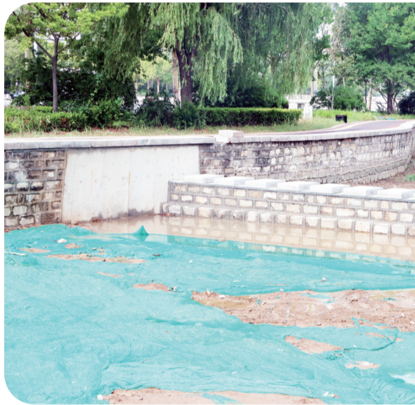
▲ 新建雨水快排通道29处、溢流坝4处。
