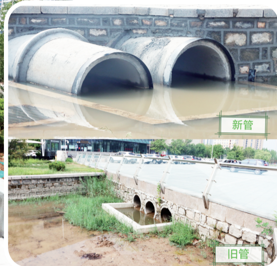
改建后的涵管相较于以往的旧管管径加粗了很多。
