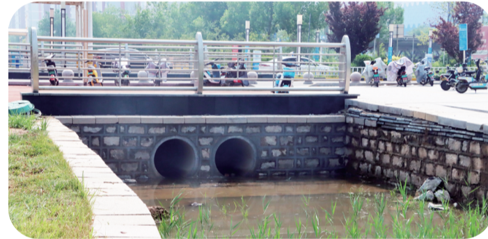
黄河十二路水系提升工程改建水系联通涵管17处。
