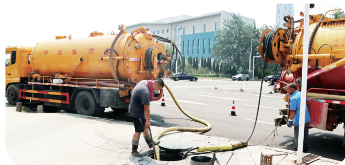
开展雨污管网疏通清淤。
