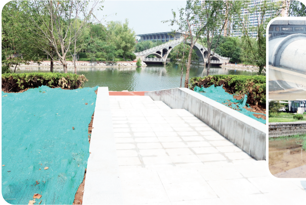
黄河九路新立河东路交叉路口通过涵管联通、台阶踏步等方式，让雨水尽快排走。
